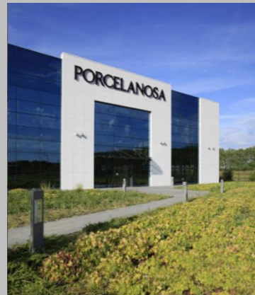
PORCELANOSA TIGERY 18,100m 2 . Almacén, oficinas y showroom
