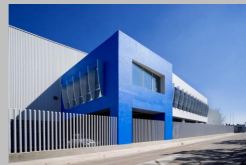
EDIPLAST , Estado de México 45,000m 2 Edificio Logístico
