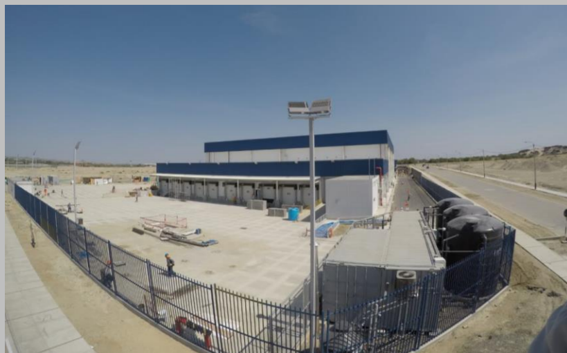
EMERGENT COLD, Piura 15,000m 2 . Almacén de Frío
