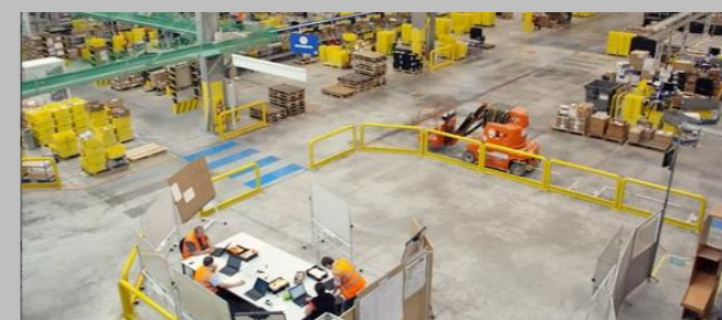
AMAZON , Orleans 25,000m 2 . Adecuación de plataforma de distribución
