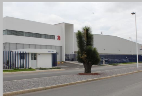
ANDAMIOS ATLAS , San Luis Potosí 13,500m 2 . Edificio Logístico
