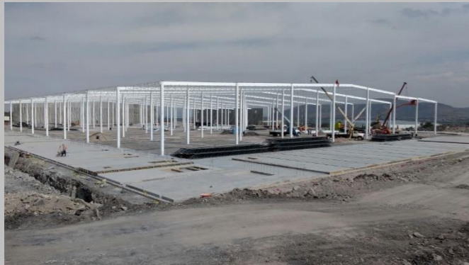
PAVISA , Estado de México 19,085m 2 . Nave Industrial y 1,500m 2 oficinas
