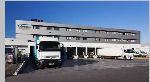
SALVESEN DANONE, Sevilla 6,400m 2 . Edificio Logístico
